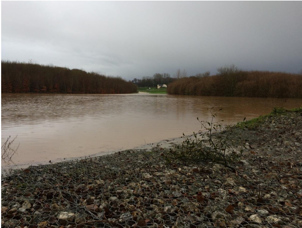
Remplissage de la Digue de Brametot ZA Autigny en amont de Fontaine le Dun
